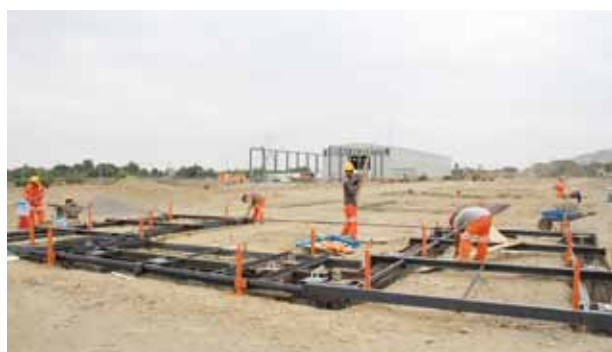
También las cimentaciones se realizan de manera prefabricada in situ
