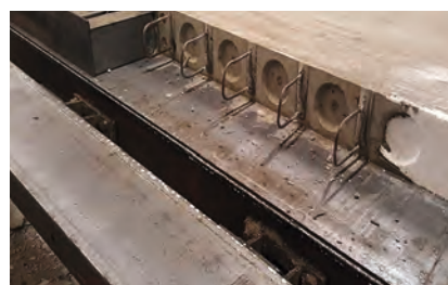
Coffrage avec clé de cisaillement et pénétration d'armature et élément fini
