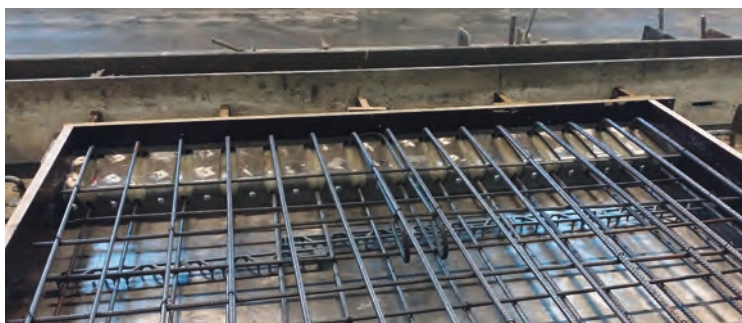
Coffrage avec caisse pour revêtement de plafond
