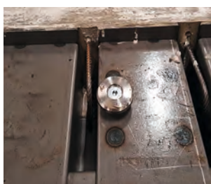
Coffrage avec clé de cisaillement et pénétration d'armature et élément fini
