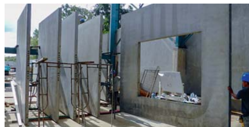
Indonésie – Production d'éléments de façades de 3,9x9 m
